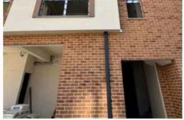
Kapadokya Degrade (Sarı üstü kırmızı geçişli)
